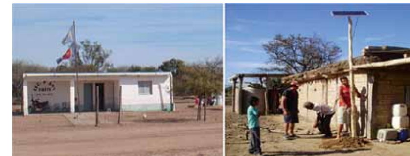
Figura 1. Escuela y vivienda típicas en entornos rurales (Departamento Pellegrini, Santiago del Estero), sin acceso a la red eléctrica
