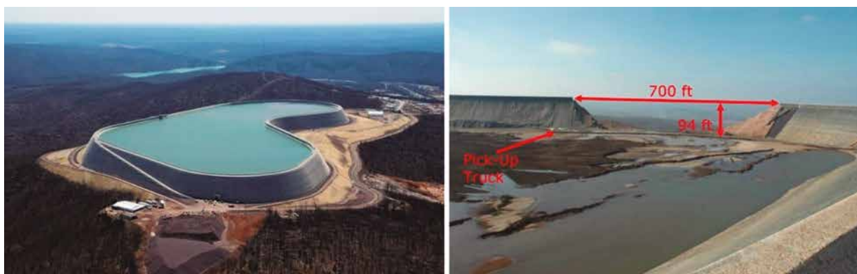
Figura 3. Central hidroeléctrica de bombeo Taum Sauk. A la izquierda, vista general del reservorio superior luego de su reconstrucción. El punto minúsculo que se ve en la pared izquierda es la caseta donde originalmente estaban instalados los interruptores de nivel. A la derecha, la magnitud del desmoronamiento producido por el desborde.
