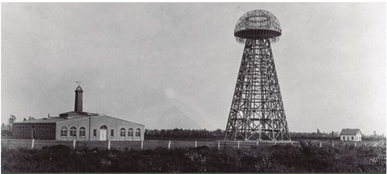
Figura 1. Proyecto de la Torre Wardenclyffe o Torre Tesla, transmisión inalámbrica de energía
