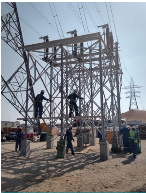
Montaje del seccionador en el desierto de Asab, en los Emiratos Árabes Unidos.
