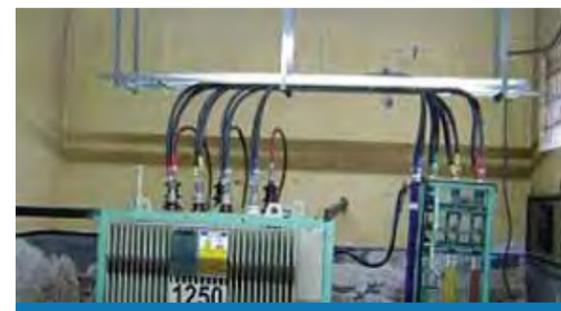
Figura 16. Conductores unipolares dispuestos en tresbolillo sobre bandeja.
