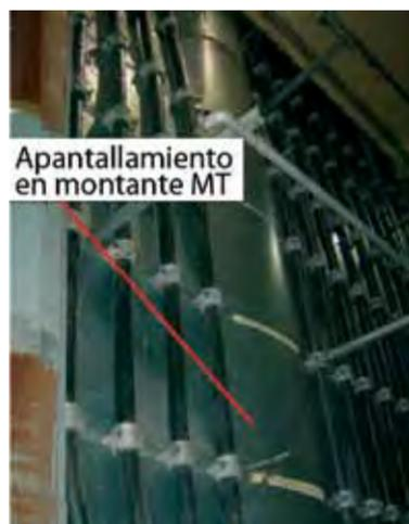
Figura 15. Instalación de pantalla magnética detrás del tablero de BT.
