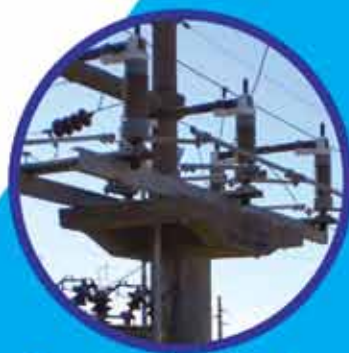
Seccionador Tripolar para uso en S/E
