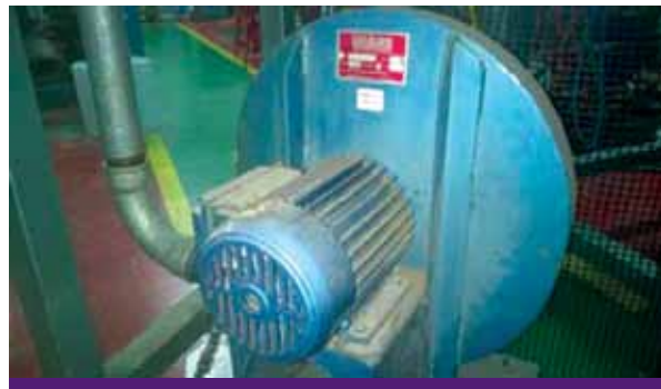
Figura 8. Conjunto ventilador-motor
