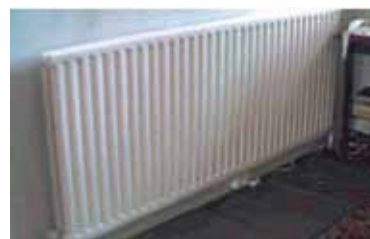
Con la cámara termográfica también es posible captar imágenes digitales
