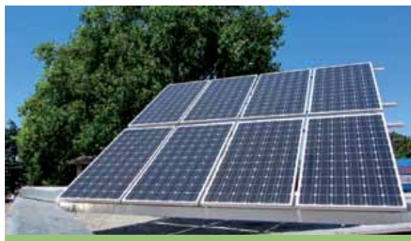
Primera instalación de Edenor de un sistema de generación fotovoltaica con inyección a la red de baja tensión.
