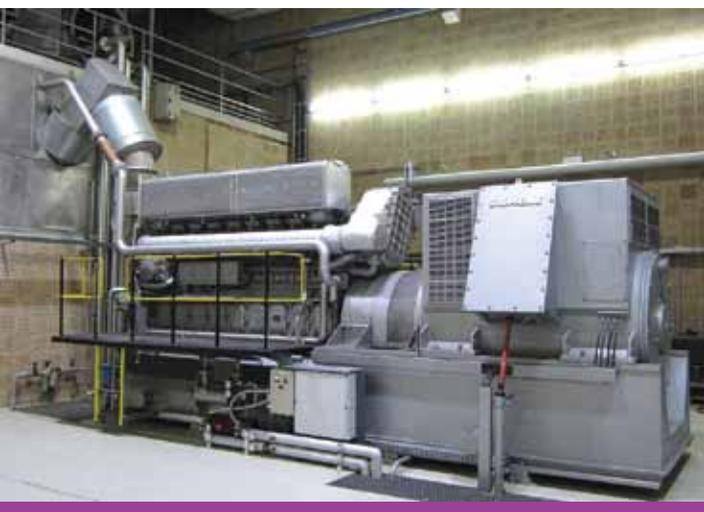
Se debe tener en cuenta que el conjunto de los elementos instalados en la cañería de escape no genere pérdidas (debido a la presión atmosférica) por la altura de escape superiores a la presión admisible por el motor.
