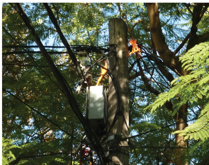
Foto2. Preensamblado en llamas
