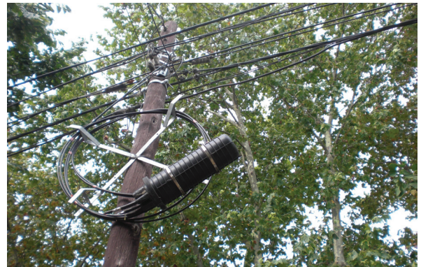
Imagen 6. Gran cruz de chapa conductora contenedora de fibra óptica sobrante y su empalme colgante, inmediatamente debajo de la línea de energía. (La fibra óptica no está tan afectada por atenuación por lo que el incremento del riesgo eléctrico atribuible a los amplificadores le va cediendo paso al entorpecimiento volumétrico que causan los empalmes colgantes y la acumulación de cables de fibra óptica que van convirtiendo a los postes de las líneas aéreas de baja tensión en depósitos a la intemperie de cables de reserva)
