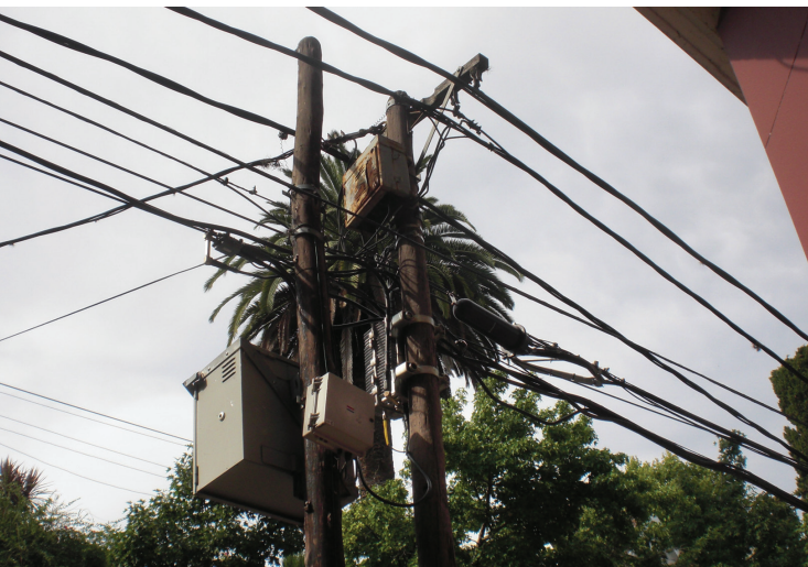
Imágenes 4 y 5. Sendas cajas metálicas de amplificadores de televisión por cable e Internet dificultan el acceso al recinto, todo oxidado de fusibles de alto poder de ruptura. (Los amplificadores están alimentados directamente de la línea aérea de baja tensión y sus cajas son siempre metálicas para favorecer la disipación de calor dado que la atenuación de los cables coaxiales se compensa con potencia)
