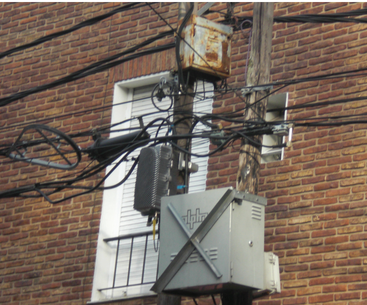
Imagen 6. Gran cruz de chapa conductora contenedora de fibra óptica sobrante y su empalme colgante, inmediatamente debajo de la línea de energía. (La fibra óptica no está tan afectada por atenuación por lo que el incremento del riesgo eléctrico atribuible a los amplificadores le va cediendo paso al entorpecimiento volumétrico que causan los empalmes colgantes y la acumulación de cables de fibra óptica que van convirtiendo a los postes de las líneas aéreas de baja tensión en depósitos a la intemperie de cables de reserva)
