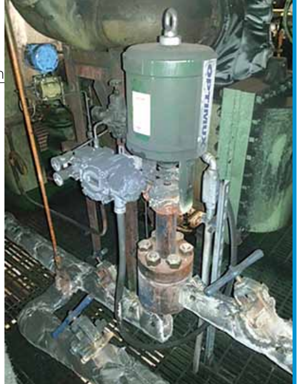
Figura 6. Válvula de 1 1/2 pulgadas en ángulo para regulación de vapor sobrecalentado a eyectores
