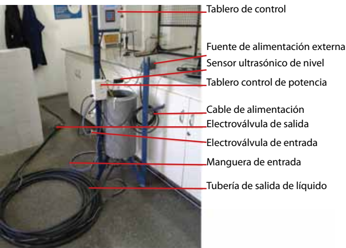
Figura 6. Planta piloto y las instalaciones
